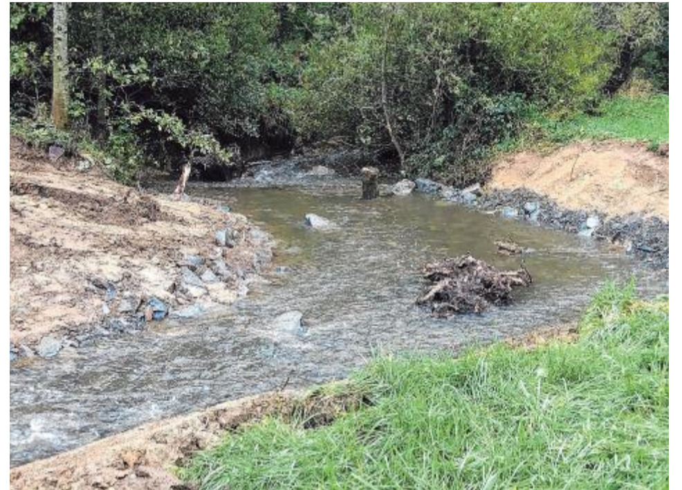
Neu gestalteter Hellerabschnitt mit Totholzblöcken und Störsteinen.
