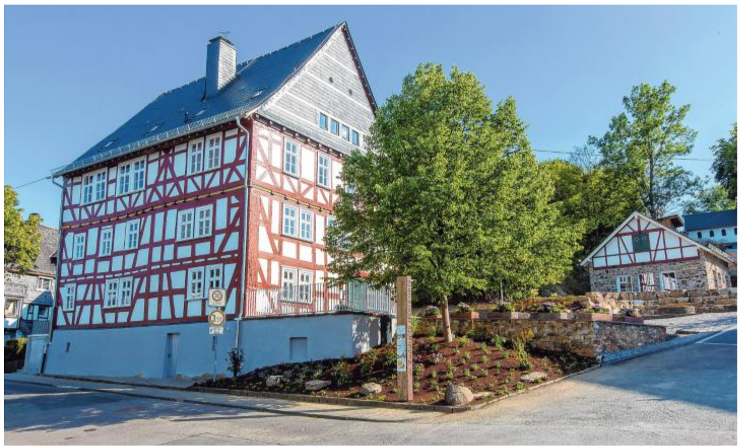
2022 wurde die denkmalgerecht sanierte Alte Vogtei wiedereröffnet.
