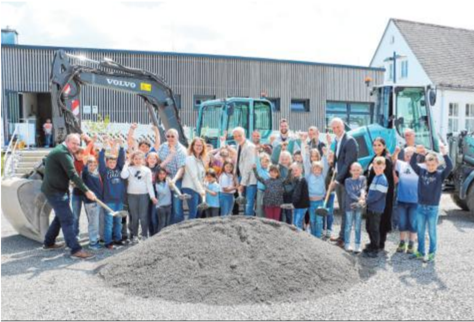
Die Begeisterung der Kinder beim symbolischen Spatenstich war groß.
