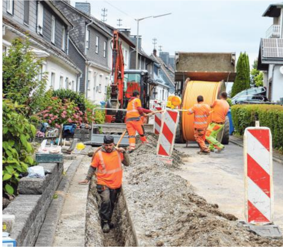
In der Goethestraße wurde mit dem Glasfaserausbau begonnen. Foto: Gemeinde Burbach
